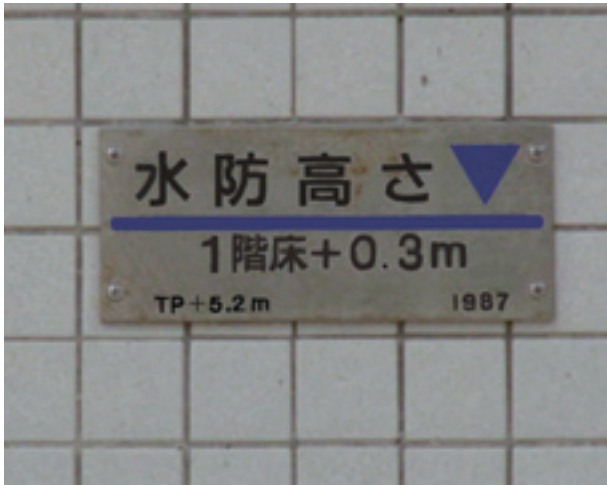
建物の外壁にこの建物の水防設計レベルを示したプレートを取り付け、後世に注意喚起を促した事例（東京都港区内の某建物）
