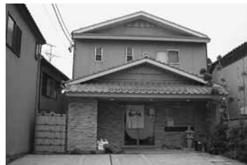
廃墟と化した商店街で唯一緑紙を貼られて営業している居酒屋。平成12年新基準以降にできたこの建物は地震に強かった。
