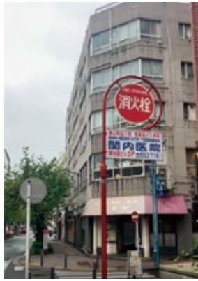
課題敷地 泰正ビル
