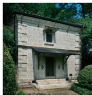
小野口家石蔵 一見積み石造（組積造）に見えるが、木造張り石蔵（厚3寸）である。築江戸末期
