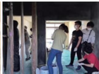
間仕切壁を作るにも墨だし、切断、建入れと苦労して作製、玄関の土間コンは、手練りにて重労働
