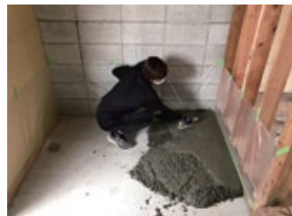
間仕切壁を作るにも墨だし、切断、建入れと苦労して作製、玄関の土間コンは、手練りにて重労働
