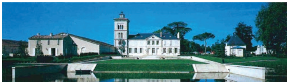
ボルドーのメドック地区サンジュリアン村 シャトー ラグランジュ
