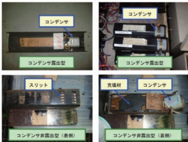
コンデンサ外付け型安定器の例 (写真は環境省通知資料より)
