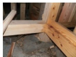
土台交換 (仕口)
