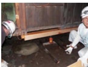
土台 ジャッキアップ
