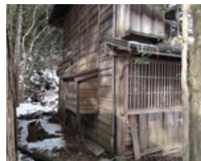
着工前 (外壁状況)
