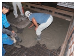
ベタ基礎コン打設
