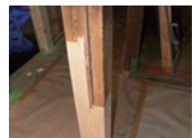
柱の尻ばさみ (継手)
